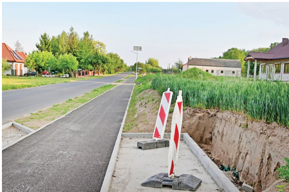
Mieszkańcy cieszą się z budowy ścieżki rowerowej, która zwiększy bezpieczeństwo rowerzystów, szczególnie dzieci
