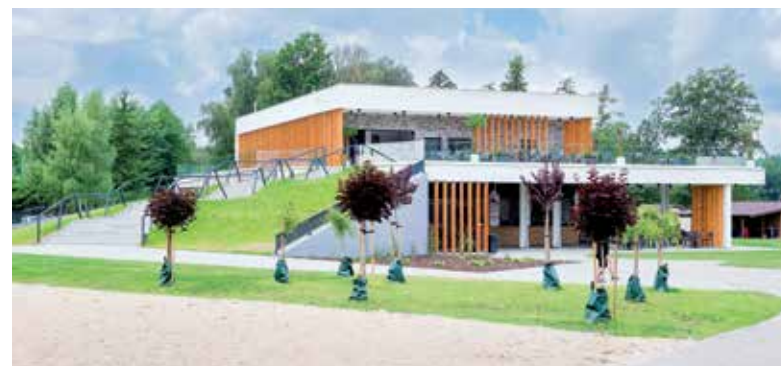
Tuż przed wakacjami oddano do użytku budynek barokawiarni
