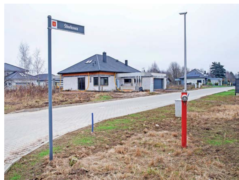
Na ul. Śliwkowej zamontowano słupy oświetleniowe z oprawami LED
