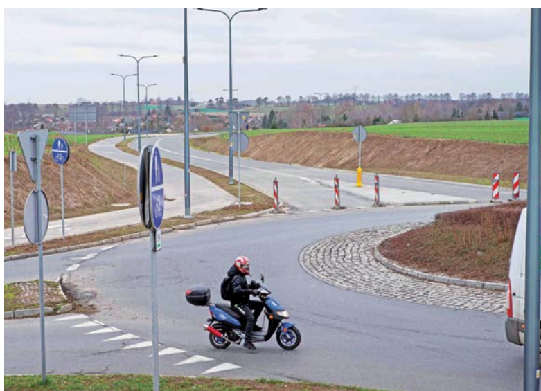
Docelowo nowa droga połączy budowaną obecnie ul. Działkowców z rondem na skrzyżowaniu ulic Laskowickiej i Miodowej.
