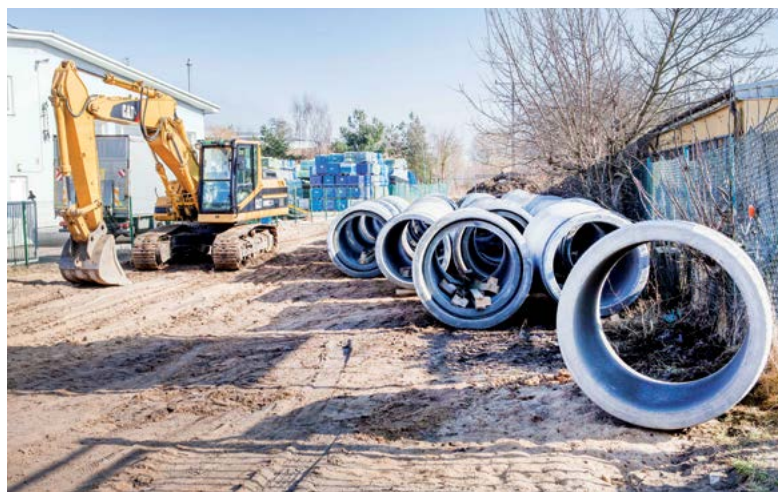
Rozpoczęła się przebudowa ul. Sławnej
