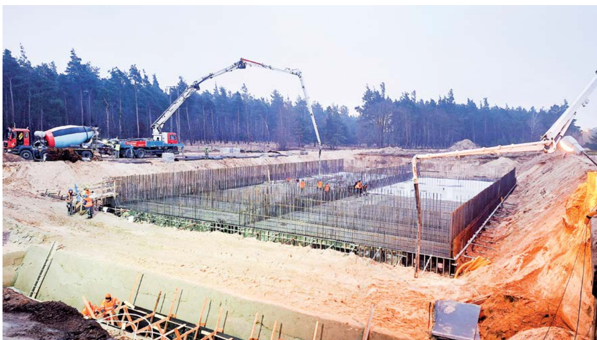
Budowa oczyszczalni ścieków komunalnych
