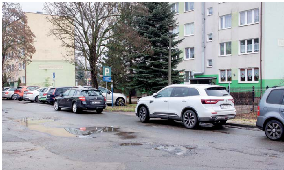
W planach jest też rozbudowa chodnika i miejsc postojowych przy Przedszkolu „Bajka”
