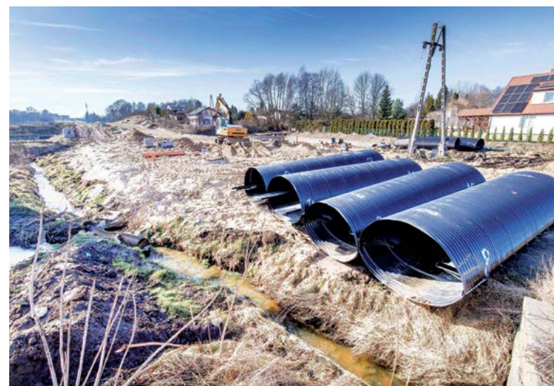
Wkrótce ruszy kontynuacja budowy ul. Działkowców
