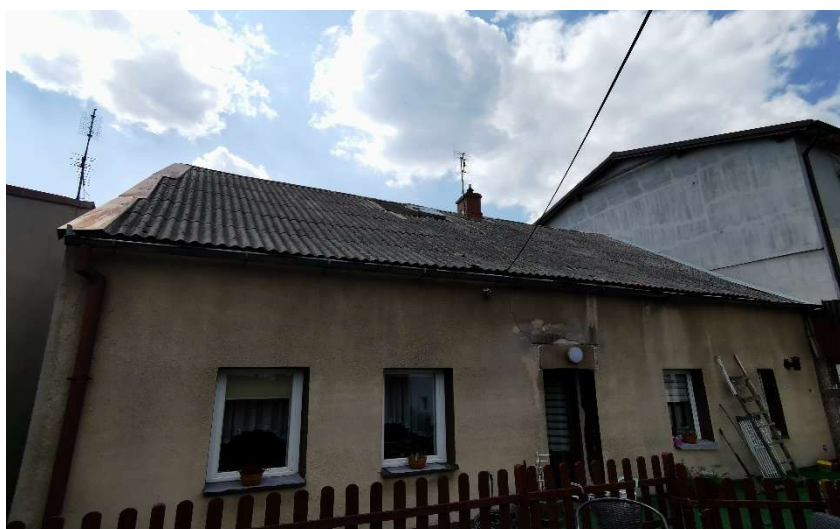
Rys. 3. Budynek mieszkalny pokryty płytą falistą azbestowo-cementową zlokalizowany w Gminie Świecie (źródło: własne).
