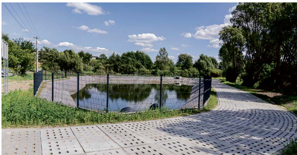
Zbiornik zatrzymuje wodę i umożliwia jej stopniowe wsiąkanie w grunt
